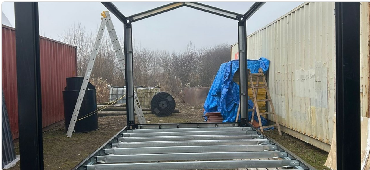
Zostavený spodný rám s podlahovými nosníkmi
