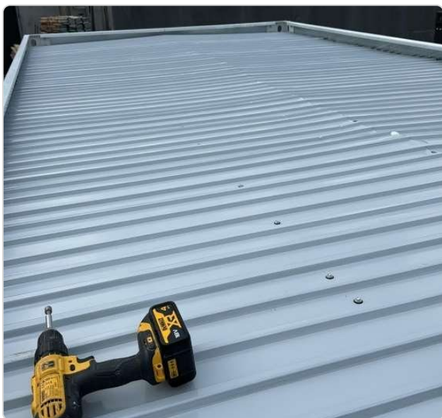
Postupné kladenie strešných panelov
