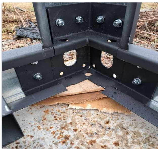
Detail skrutkového spoja rohového stĺpika
