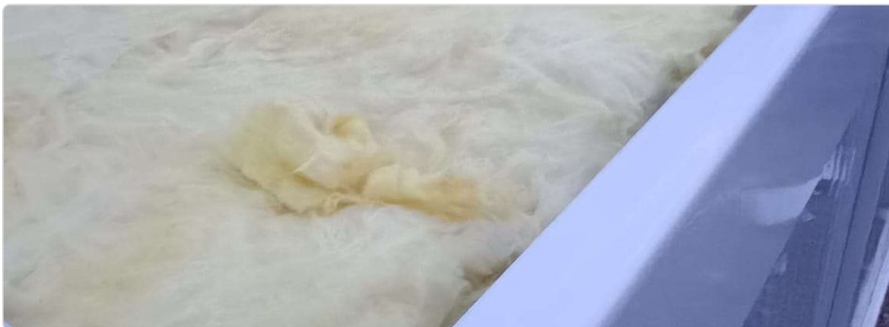
Rozloženie tepelnej izolácie po celej ploche strechy
