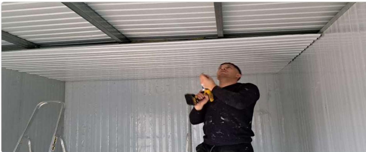
Kotvenie stropného plechu k strešnej konštrukcii
