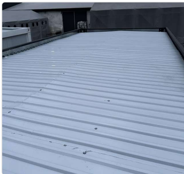
Dokončená plechová strešná krytina
