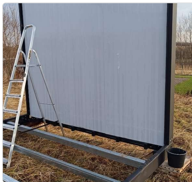
Osadené okno v bočnej stene
