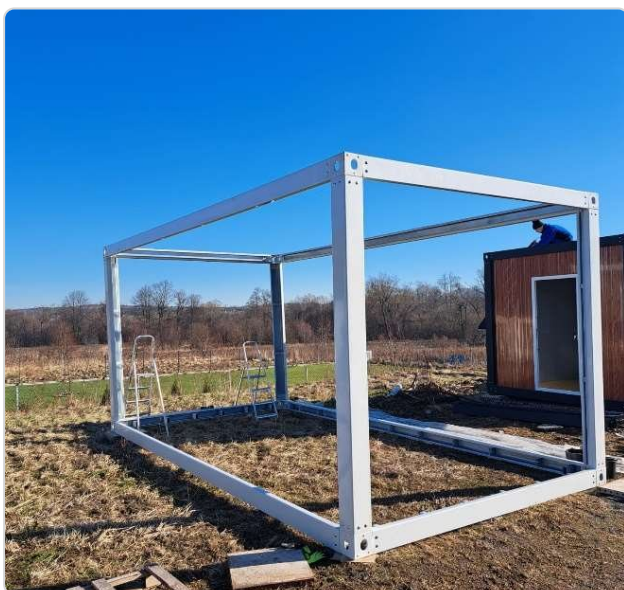
Zostavený rám kontajnera pripravený na podlahové nosníky
