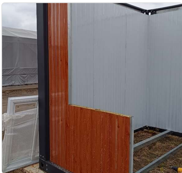
Montáž steny s otvorom pre dvere
